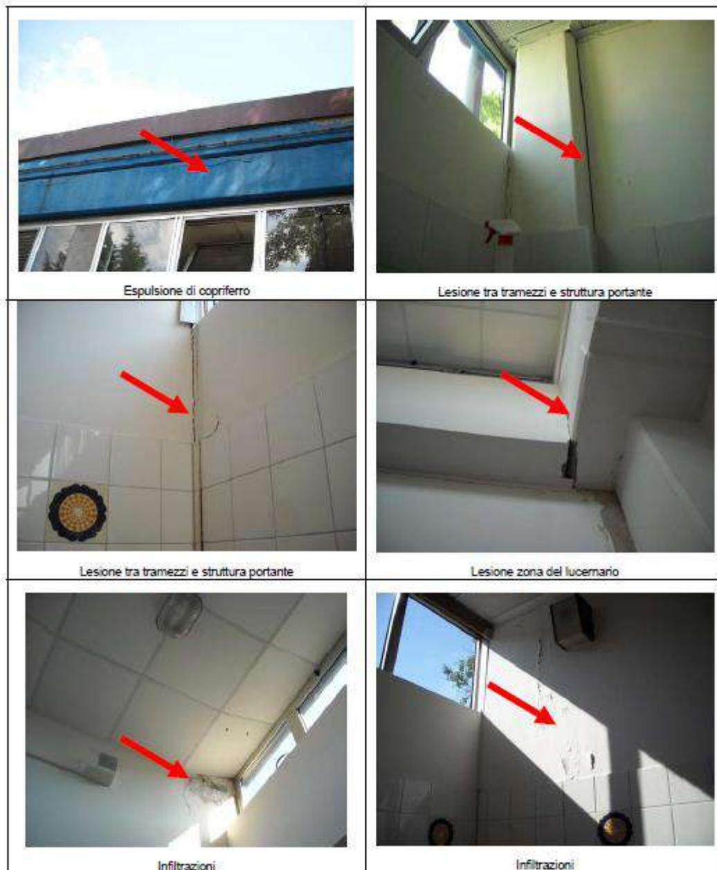
Figura 4- Alcune foto del quadro fessurativo e/o di degrado
