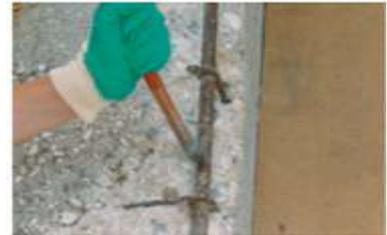
Fase 2 Si procede con l'applicazione della boiaccia cementizia monocomponente tipo Fassifer Mono o bicomponente BF 501 o similare, contenente additivi che hanno la funzione di proteggere i ferri d'armatura dai fenomeni di corrosione; la boiaccia svolge anche la funzione di ponte di adesione tra il supporto esistente e la malta per il ripristino applicata successivamente. I prodotti si caratterizzano per la colorazione azzurra che ne facilita l'individuazione a stesura avvenuta.
