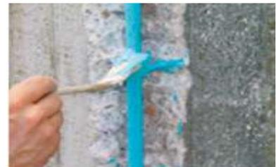
Fase 3 Dopo aver lasciato trascorrere almeno 4-5 ore dal trattamento antiruggine dei ferri d'armatura, prima di applicare la malta per il ripristino, si deve bagnare a rifiuto il supporto. Si adotterà un prodotto tipo Geoactive Top B 525, ovvero una malta cementizia monocomponente, fibrinforzata, tixotropica, a ritiro compensato, contenente cemento solfato resistente, spruzzabile, per la riparazione e ricostruzione di strutture in calcestruzzo
