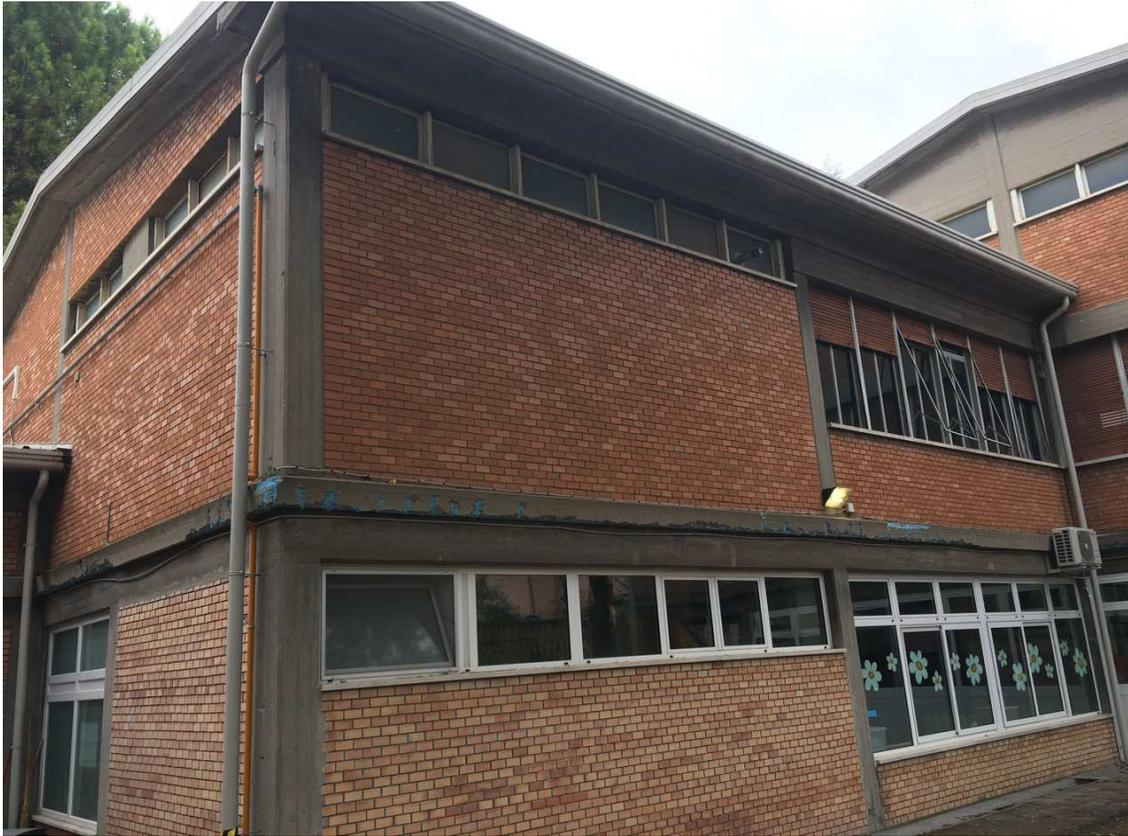
Foto 1 – particolare strutture in C.A. da risanare e infissi il primo piano da sostituire
